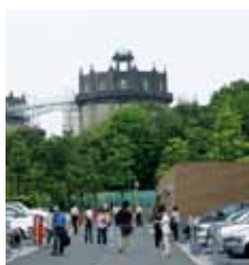
歴史あるたたずまいの駒沢給水塔
