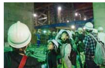
下北沢駅の地下工事現場
