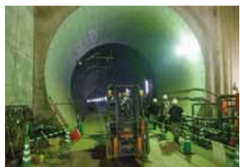
世田谷代田駅の地下工事
